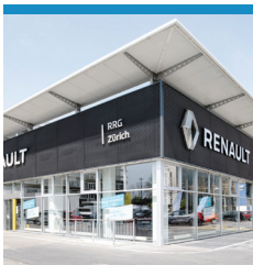
GLATTBRUGG (ZH) Thurgauerstrasse 101, 103
